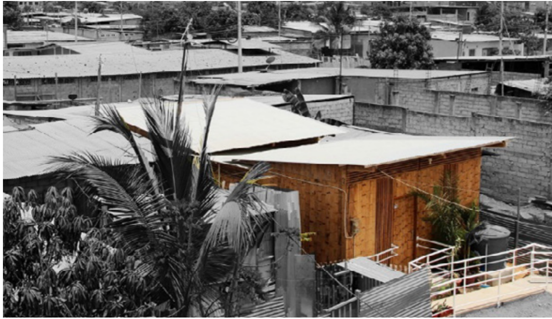
Fig. 6 - Vivienda nueva de la Sra. Gloria Guerrero. La "Casa Gloria" se construyó en el mismo predio que la original. Es un laboratorio viviente para una tipología de vivienda social basada en fibras naturales. Monte Sinahí, Guayaquil, Ecuador. Fuente: Propia.
