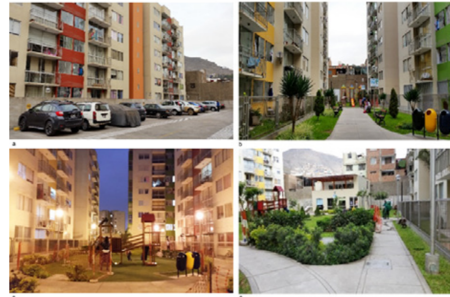
Fig. 7 - Caso B: (a) estacionamiento a desnivel que fragmenta la conectividad espacial. (b) E3-B, espacio percibido como privado por su mayor cerramiento. (c) E5- B y E1- B: espacios de similar jerarquía y equipamiento, ubicados en los extremos como puntos de llegada, pero sin conectividad entre sí. Fuente: Archivo propio.
