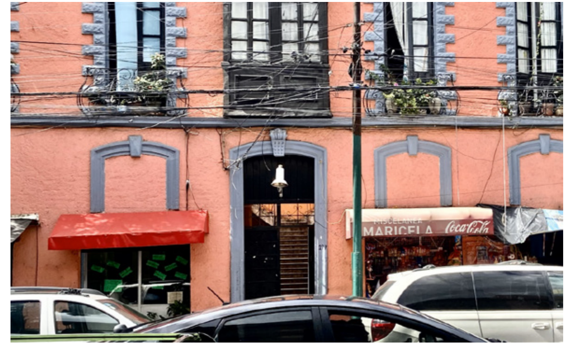
Fig. 4 – Fachada de la vecindad en Manuel Carpio 197, colonia Santa María la Ribera: Piña De la Teja, Saymar 2022
