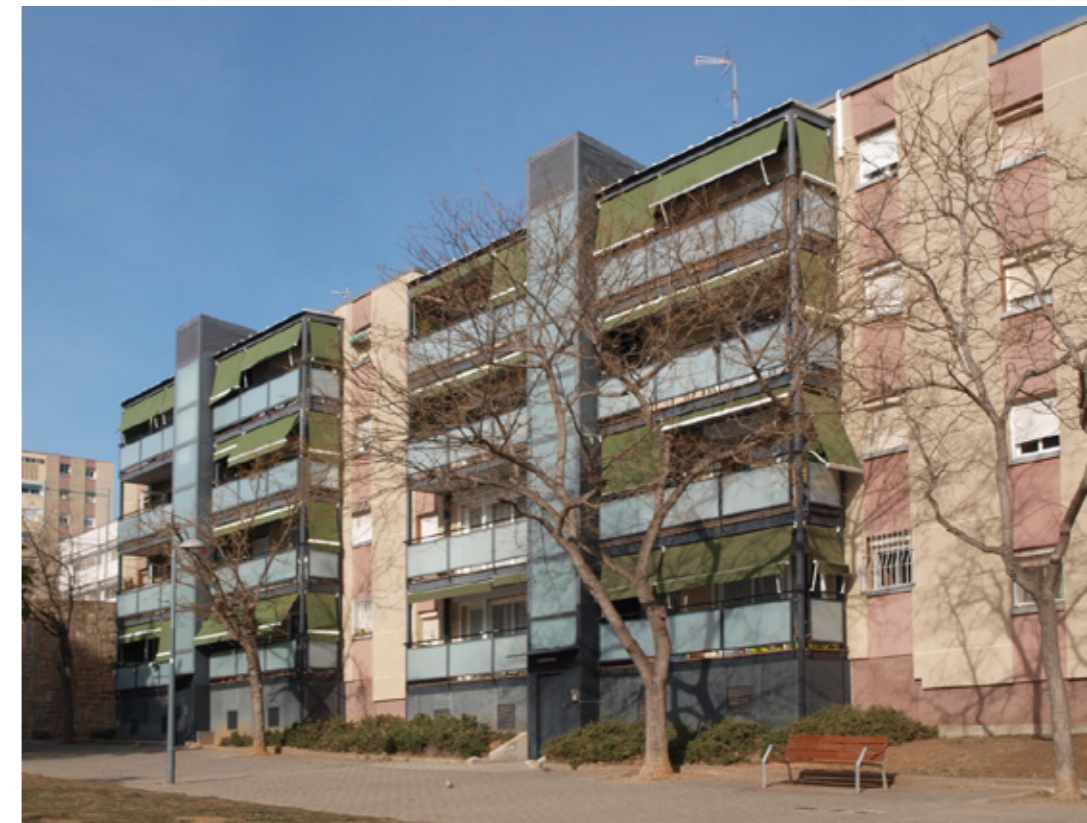
Fig. 5 - Instalación de ascensores en fachada: bloque de viviendas en Guineueta. Nou Barris, Barcelona, 2012. Fuente: las autoras.
