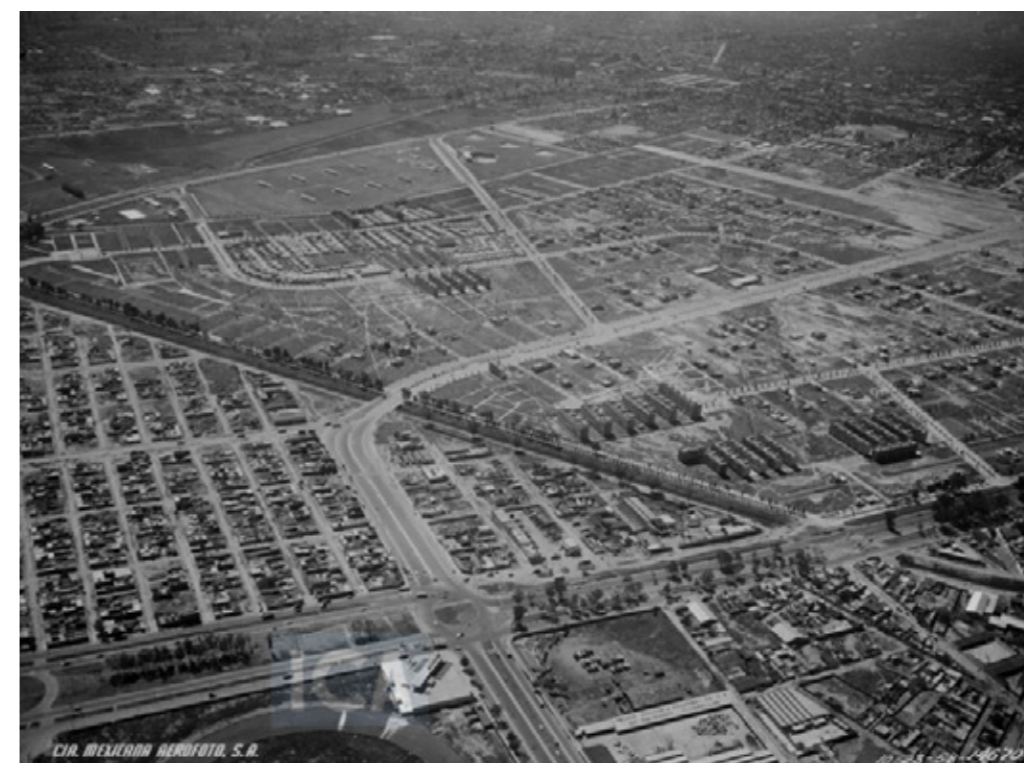
Fig. 3 – Vista suroeste de la colonia Jardín Balbuena (al centro) en 1958. Se aprecian los edificios multifamiliares, las supermanzanas y los lotes para vivienda unifamiliar con muy pocas construcciones. Fuente: Colección digitalizada de la Fundación ICA A.C.
