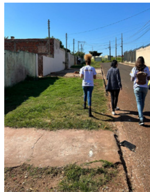
Fig. 5 - Imagem da falta de pavimentação no passeio de uma das ruas do NHSF. Fonte: Maysa Battistam, 2023.
