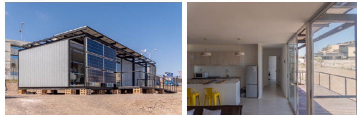
Fig. 35 Fachada con integración de paneles fotovoltaicos en fachada vertical y cubierta horizontal. Fuente: J. Guerra
