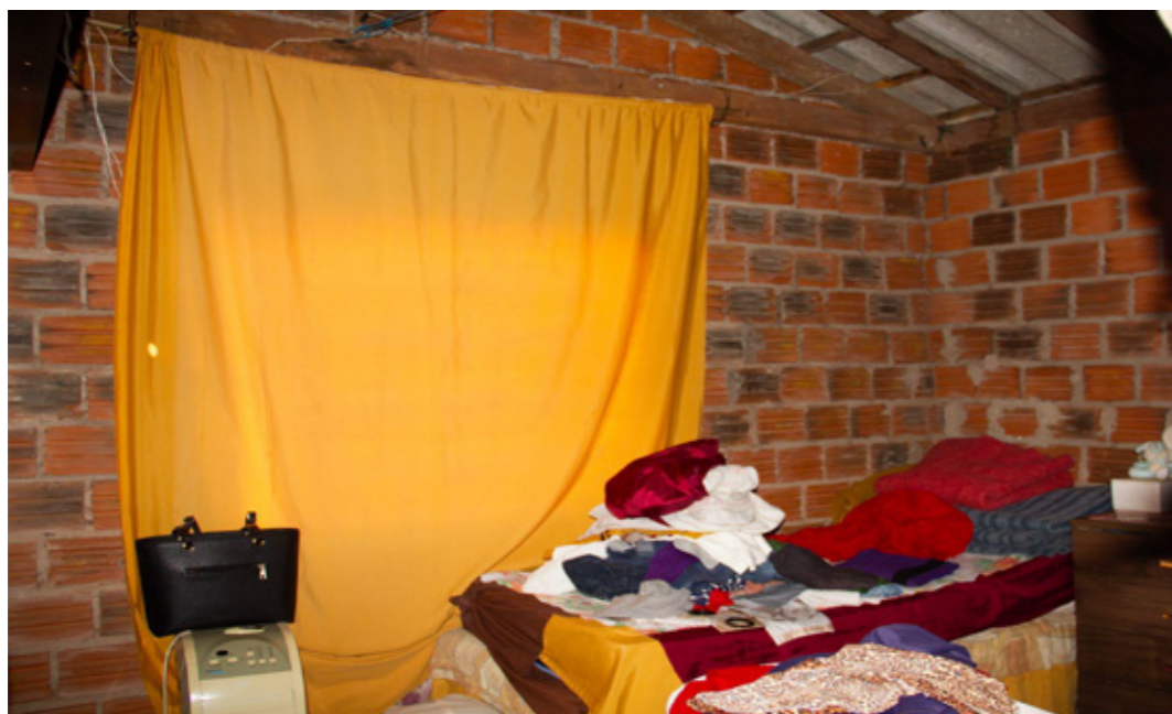
Fig. 4 - Perspectiva de uma das residências, na qual percebe-se a ausência de pilares e vigas. Fonte: Gabriela Soares, 2023.
