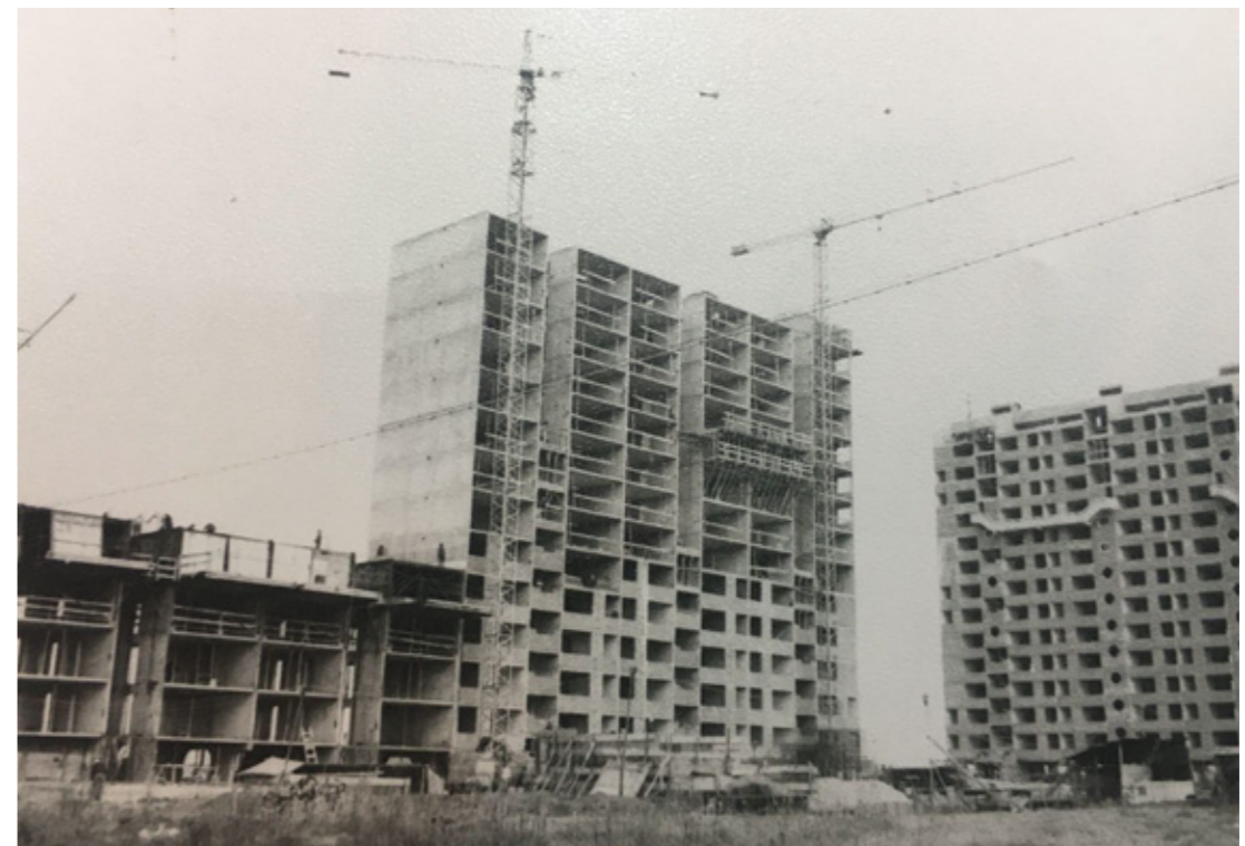
Fig. 3 - Fotografía del conjunto en construcción. Tomada por J. C. Abella Trías. Archivo Liga de la Construcción.
