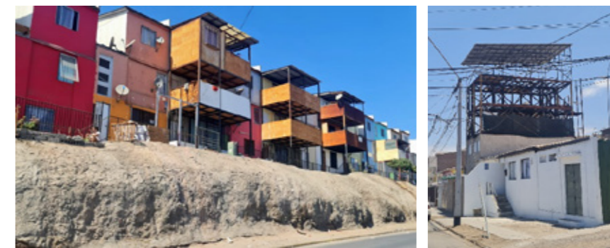
Fig. 26 y 27 Ampliaciones de viviendas sociales de construcción formal. Fuente: J. Guerra.
