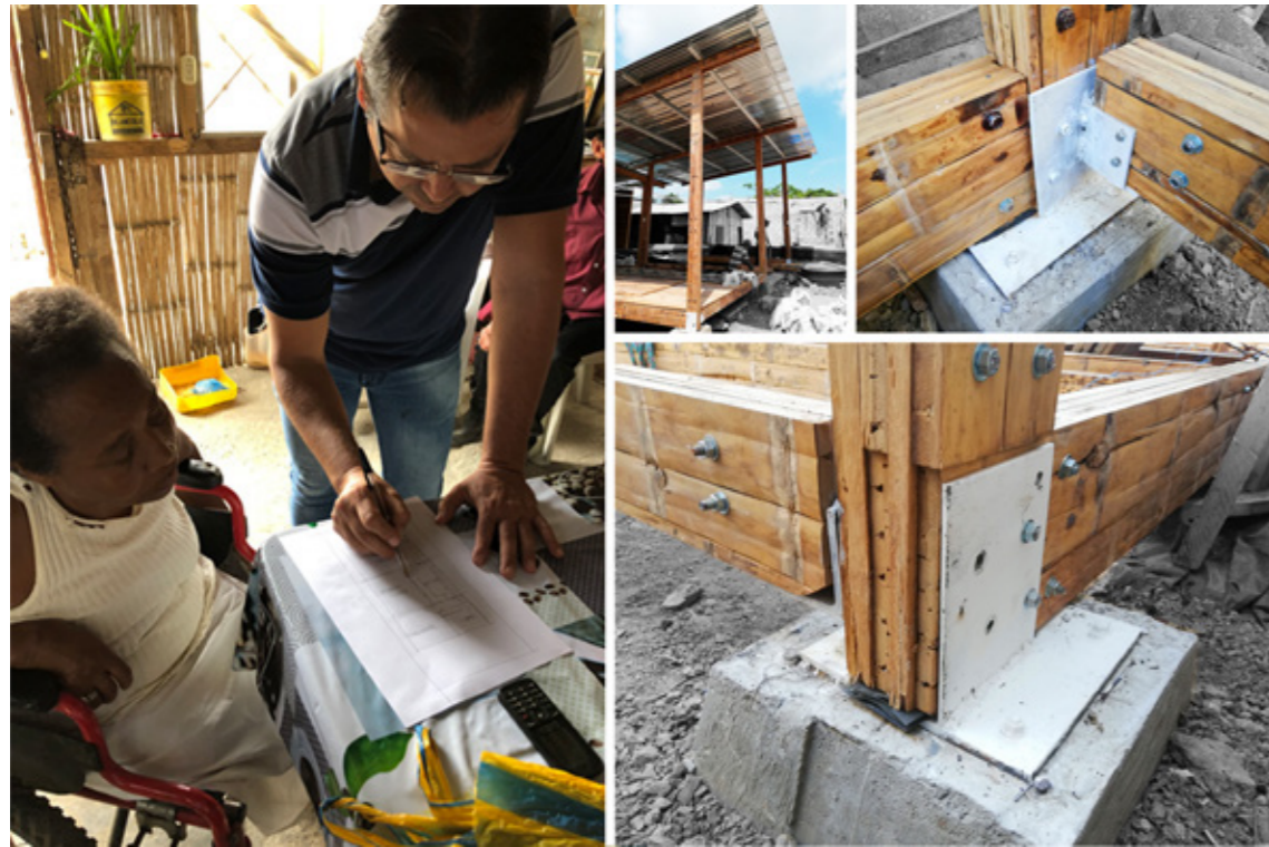
Fig. 4 - Diseño participativo con la Sra. Gloria Guerrero y detalles constructivos del sistema estructural a partir de tableros de PlasBam de bambú guadua. Monte Sinahí, Guayaquil, Ecuador. Fuente: Propia.
