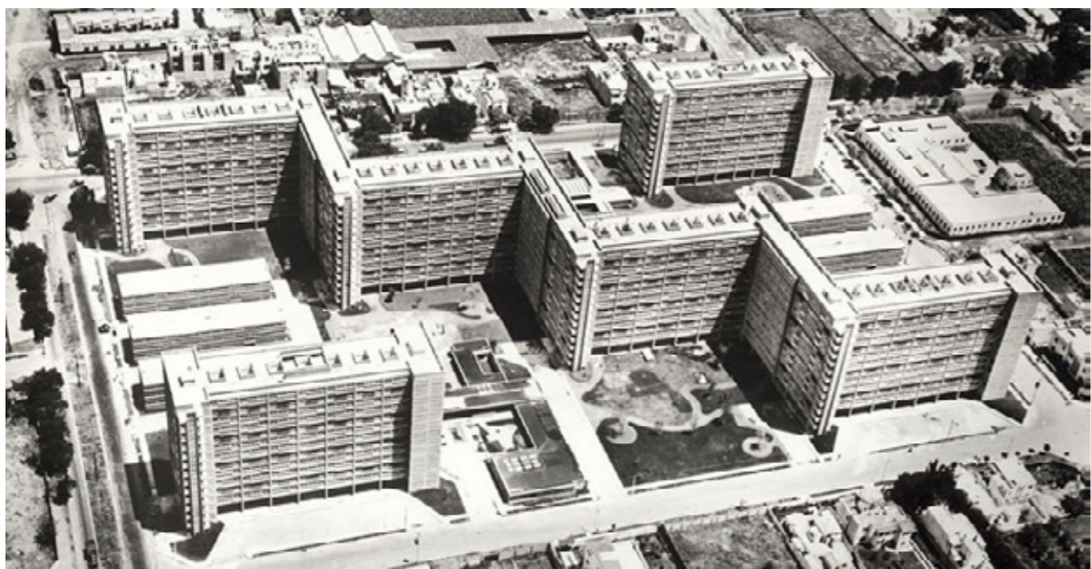
Fig. 1 - Vista aérea del Centro Urbano Presidente Alemán. Fuente: https://arquine.com/pani-y-la-vivienda-colectiva/
