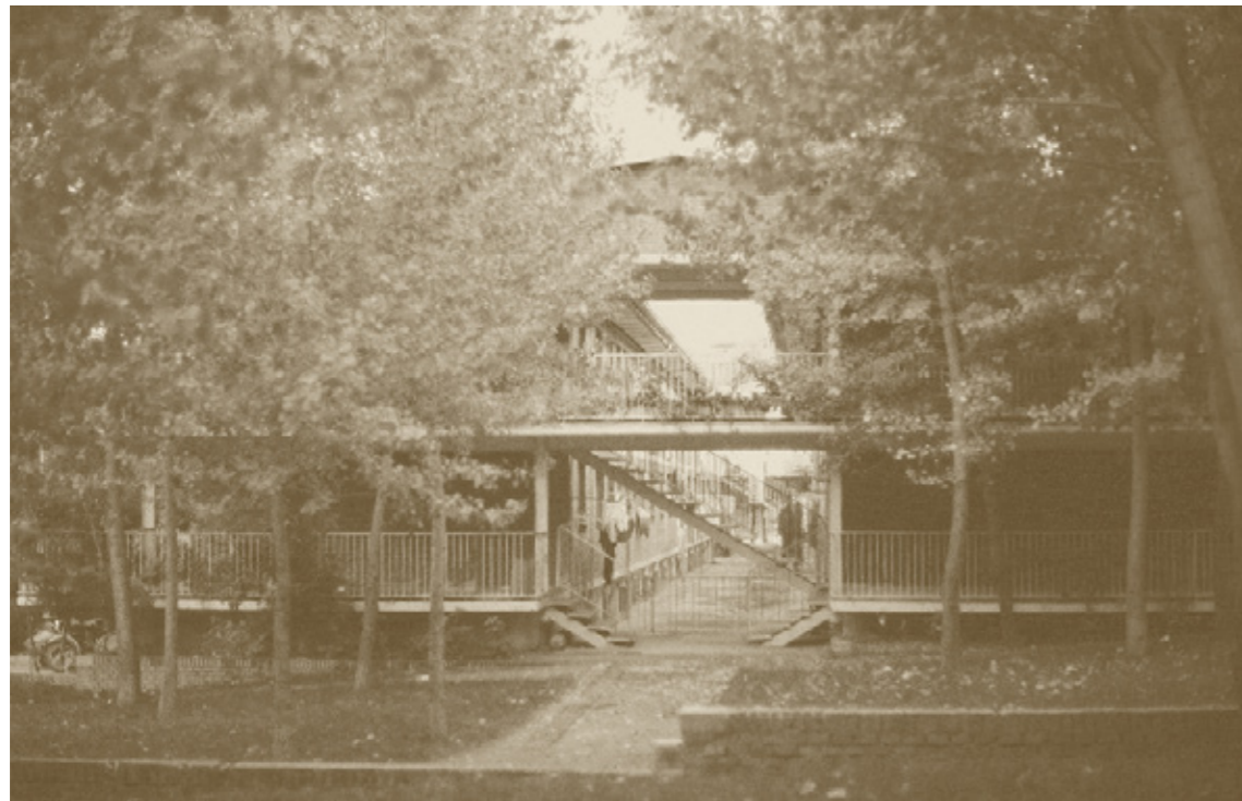
Fig. 3 - Vista de la entrada de una de las unidades. Fuente: Fundación Fernando Higuera.
